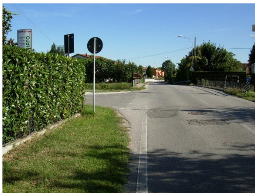
Ponte di via Cavalleggeri sul fiume Zero
